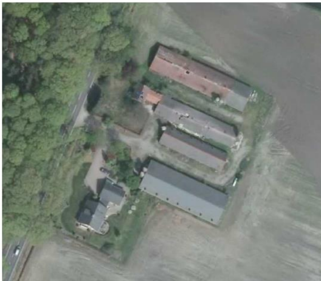
Foto: situatie Kruisberglaan 17, voor sloop bedrijfsgebouwen
