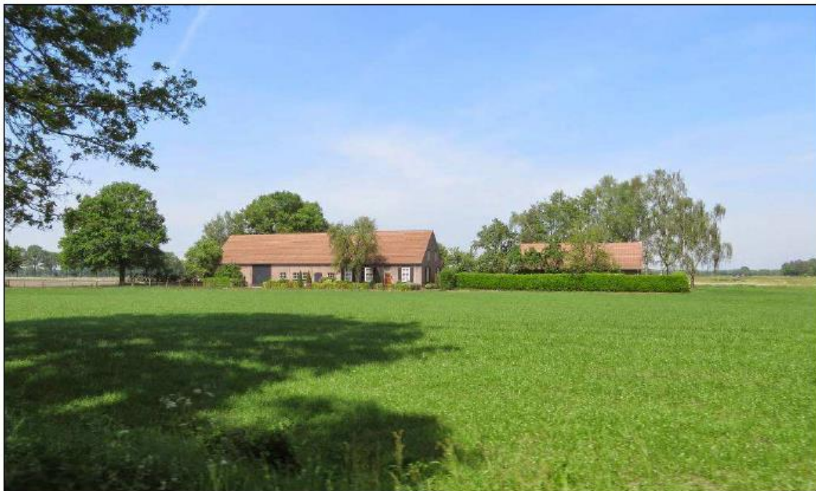
Figuur 1: bestaande situatie Zand 9
