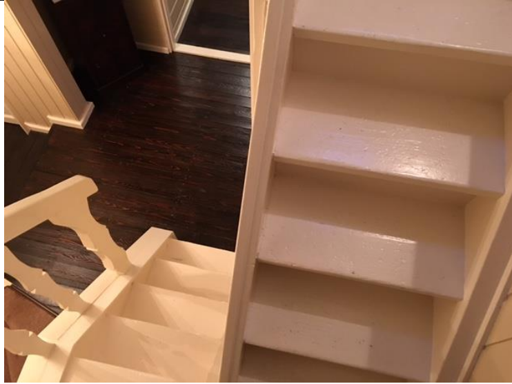
Trapconstructie naar opkamers en bovenruimte
