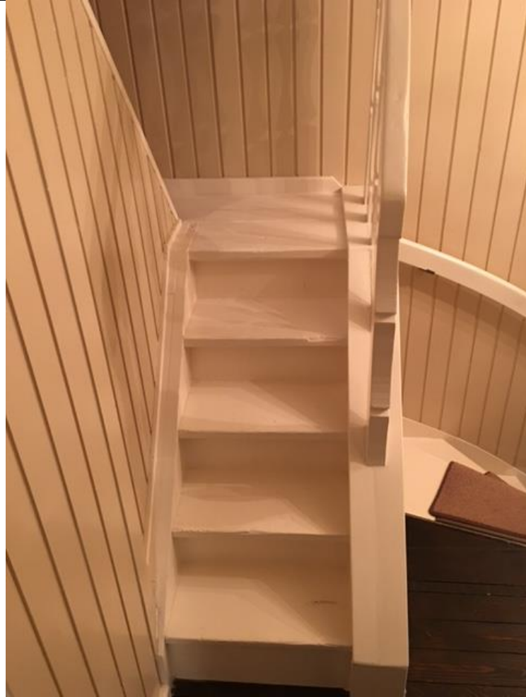
Trapconstructie naar opkamers en bovenruimte
