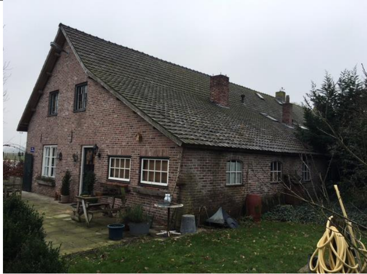
Achterkopgevel, en achtergevel met stalramen.
