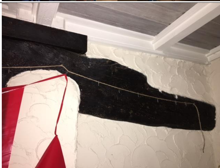
Detail Verwerking Balk in de draagmuur
