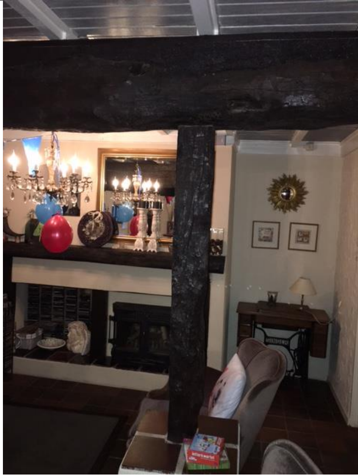
Detail Balkenstructuur en stookplaats
