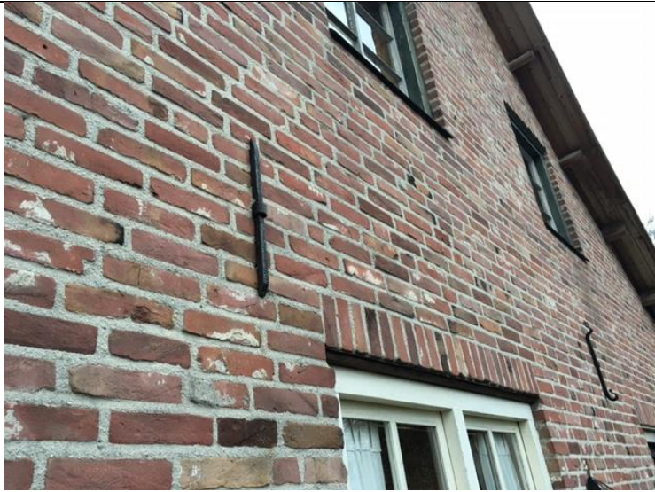
Detail muurankers van de balklagen
