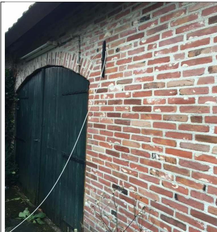
Detail muurankers en staldeur
