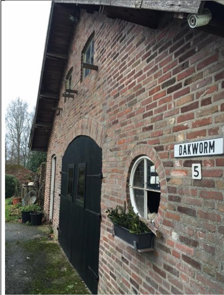
Achtergevel stal met staldeur
