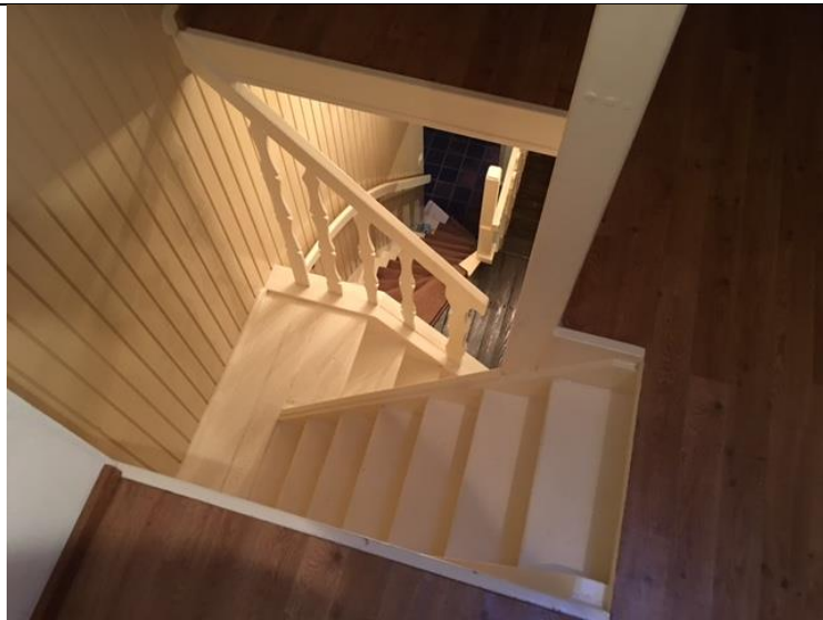
Trapconstructie naar opkamers en bovenruimte
