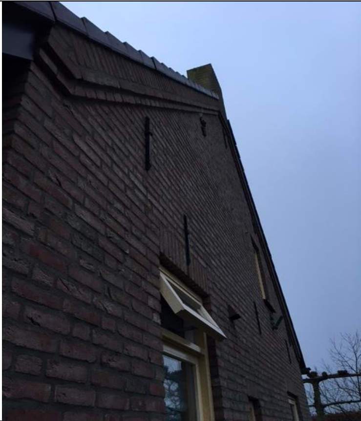
Detail muurankers en dakafwerking
