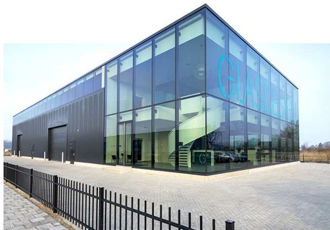
Gevelreclame geïntegreerd in het ontwerp (Broos de Bruijn Architecten)
