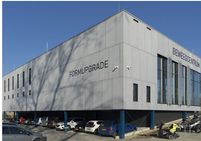
Gevelreclame met losse letters, onderdeel van het ontwerp (Factor Architecten)
