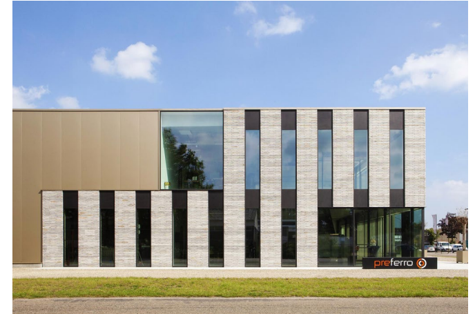
Verschillende gebouwdelen in één samenhangende bouwmassa (Van Houtum Architecten)
