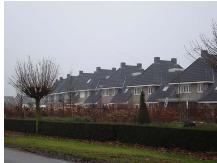
Woningen aan de Groeskuilen: de Paashoef
