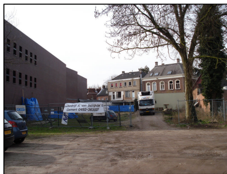
Foto 3. achter de gebouwen aan het ridderplein zijn al werkzaamheden aan de gang.
