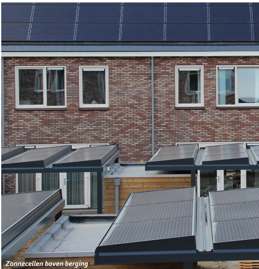
Zonnepanelen in een regelmatig patroon in overeenstemming met de dakvorm
