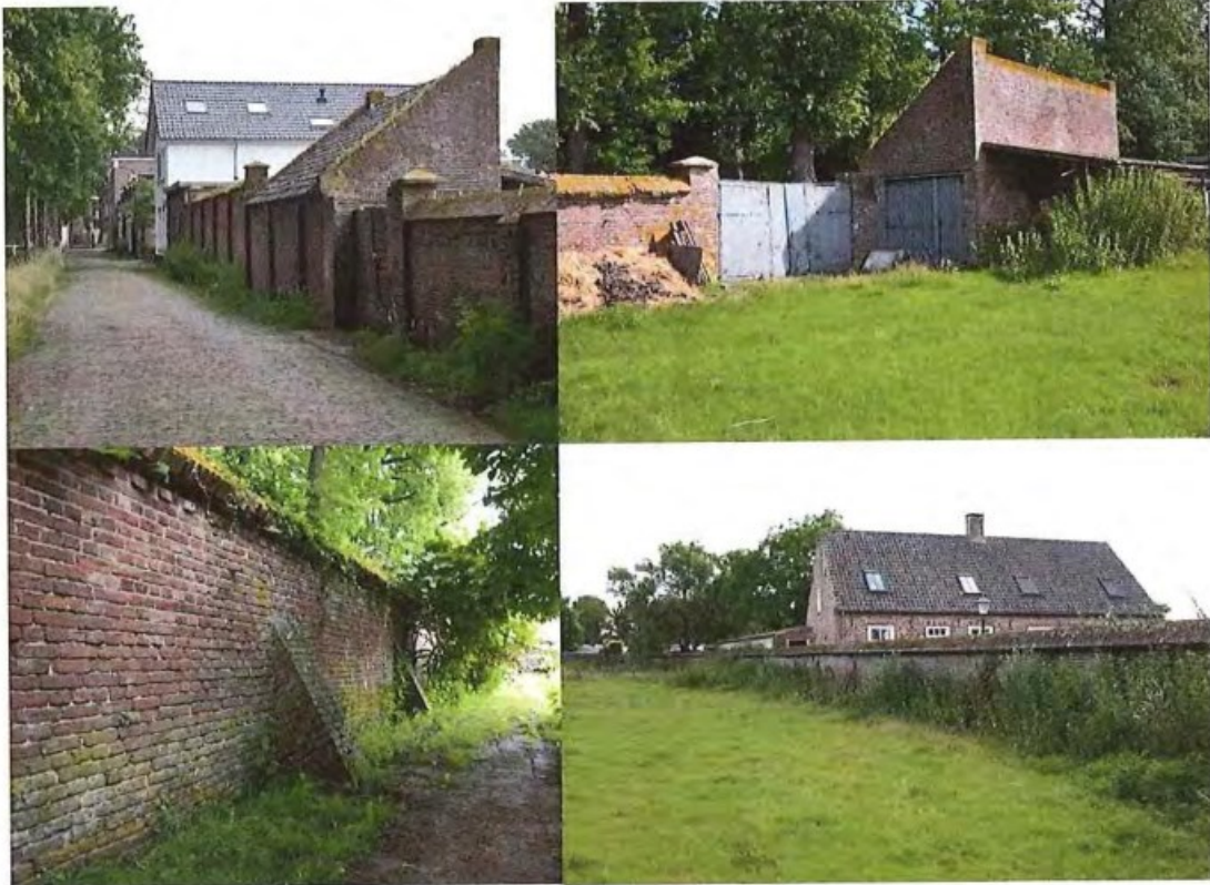
Figuur 2.1: Foto's tuinmuur gemaakt op 7-7-2021 door Constructiebureau de Prouw
