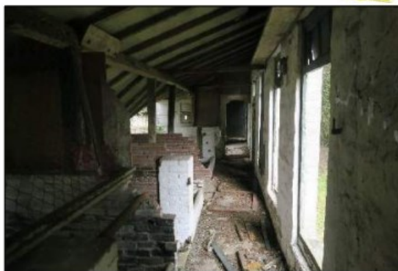
Foto 6. Binnenkant van een van de schuurtjes
