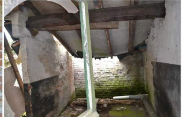
Dak ter plaatse van B-02-01
