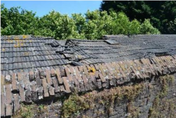
Panbedekking op dak B-02-01
