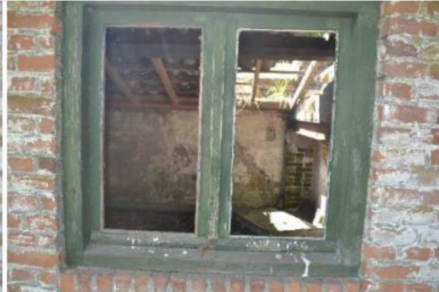
Raamkozijn in gevel van B-02-01
