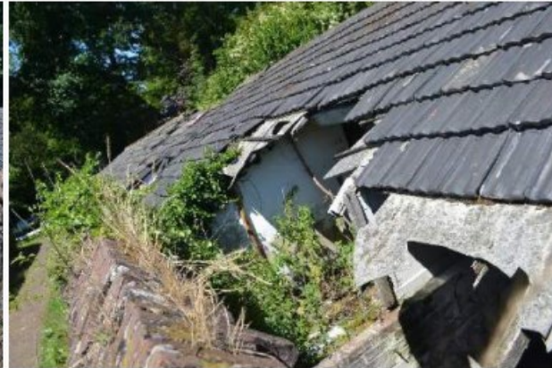
Panbedekking en constructie van dak B-02-01
