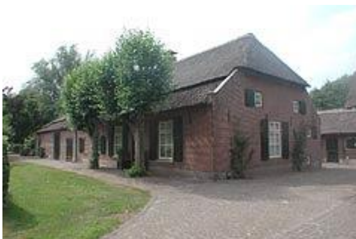
Figuur 8 - Voorbeeld van een langgevelboerderij
