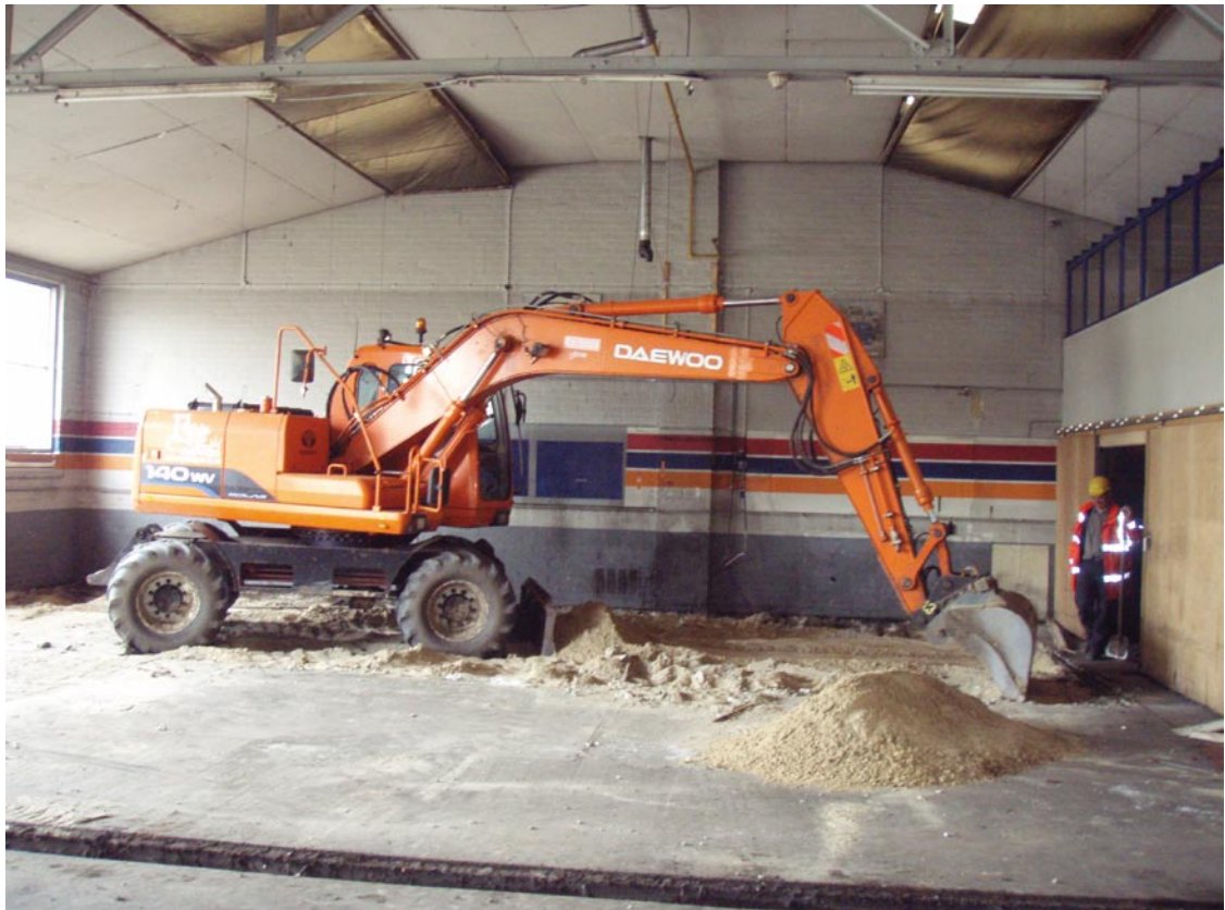
Figuur 2.2 Aanleg van werkput 2.
