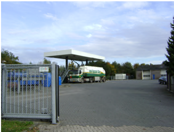
Figuur 2 Open toegangshek tot terrein
