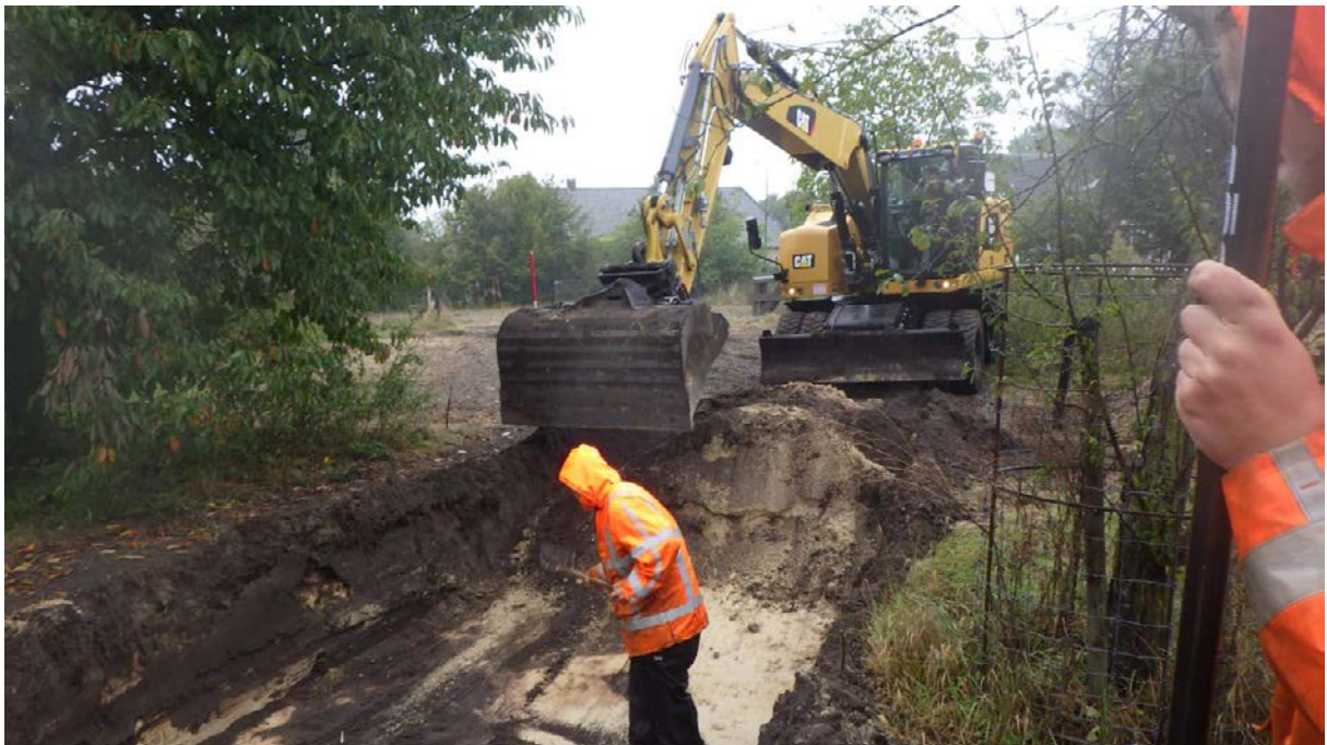
Fig. 1.2. Gemert-Deel. De aanleg van proefsleuf 5.
