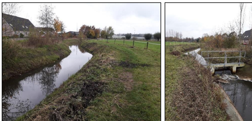
Afb. 2.7 Links; Molenbroekseloop met daarlangs het karrespoor vanuit het oostelijke deel van het plangebied in westelijke richting. Rechts; stuw in de Molenbroekseloop met aan de linkerkant het karrespoor en aan de rechterkant de wadi (foto: E.A.M. de Boer, 19-11-2021).
